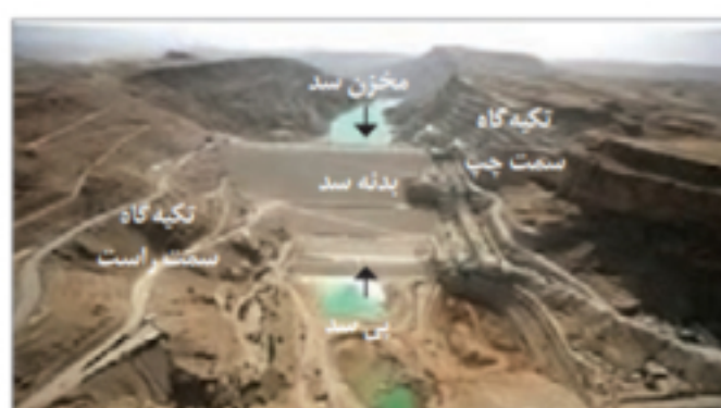
شکل ۴-۵. نمایی از بخش های مختلف یک سد
