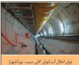
تونل انتقال آب (تونل کانی سیب - پیرانشهر)
